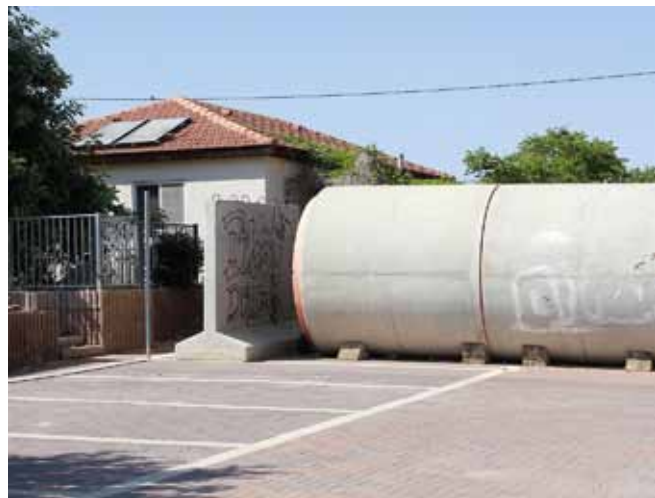
„Betonschläuche“ nennen Israelis die lebensrettenden Bunker zwischen zwei Häusern.
